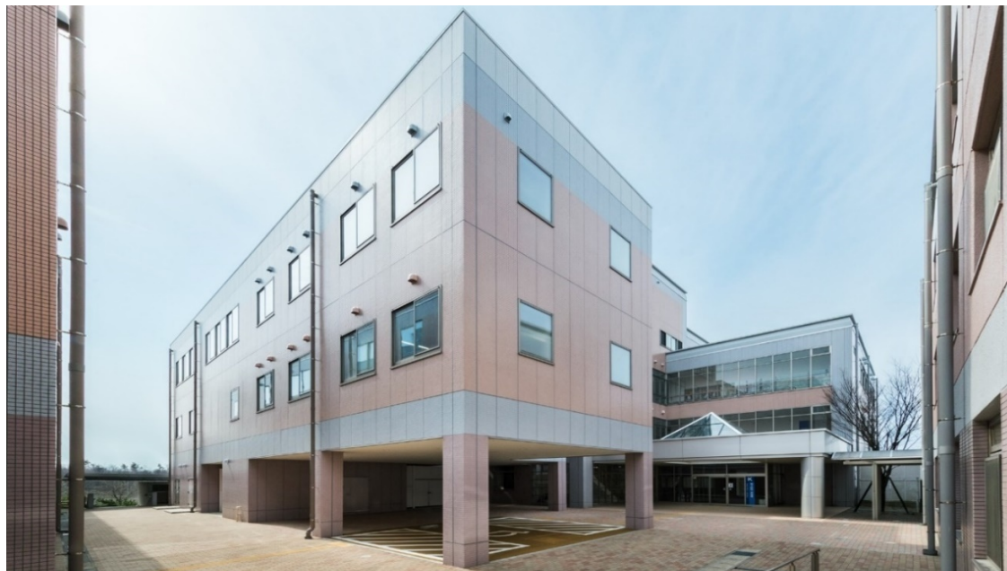
【第4研究・実習棟 増築部外観】
